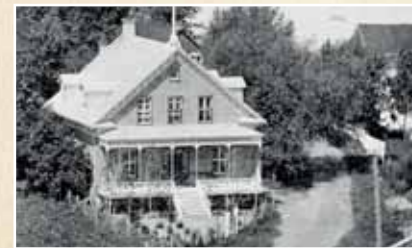
La maison De la Boissière vers 1903
