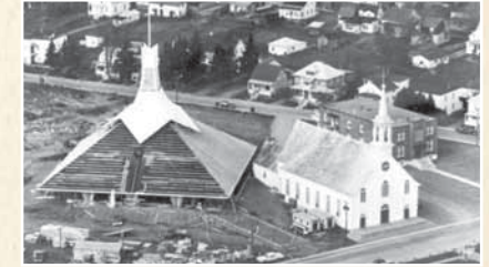
Mai 1967, la nouvelle église côtoie l'ancienne
