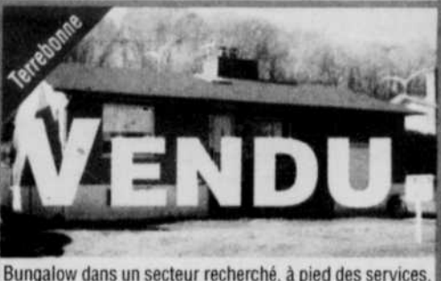
Terrebonne Bungalow dans un secteur recherché, à pied des services, 3+1 chambres, foyer, piscine creusée, bachelor, garage. Faut voir! vendeur motivé.
