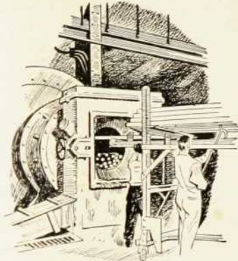
Chargement des tiges d'acier dans un des broyeurs cylindriques de l'usine de Nickel à Copper Cliff.
