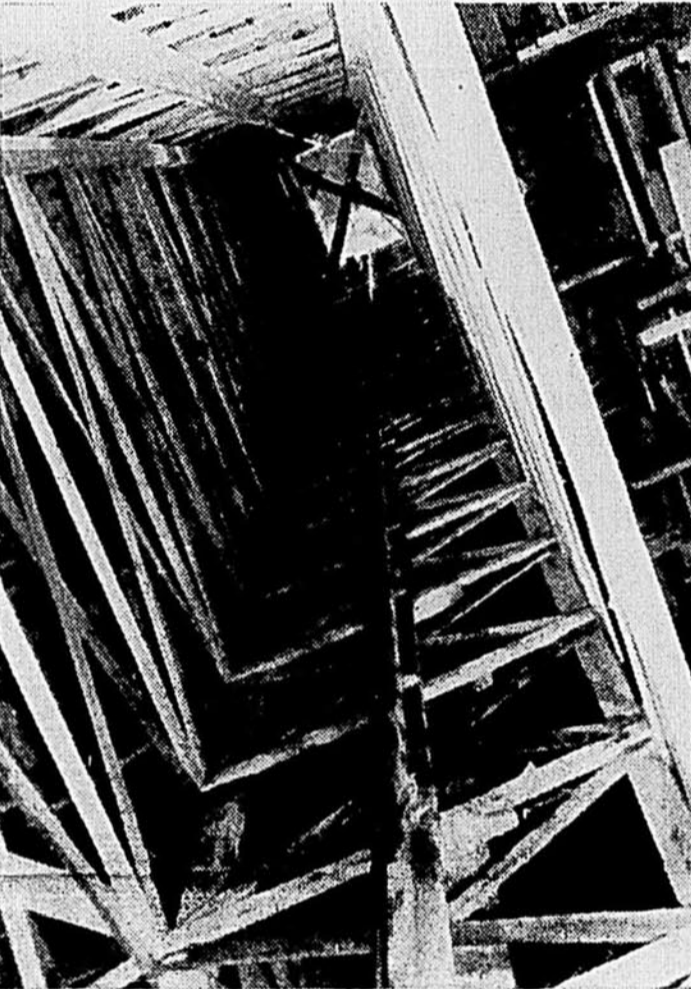
Voici l'échafaudage intérieur dans lequel était installé le monte-charge fatal qui a causé la mort de quatre jeunes gens vendredi dernier à l'Oratoire St-Joseph.
