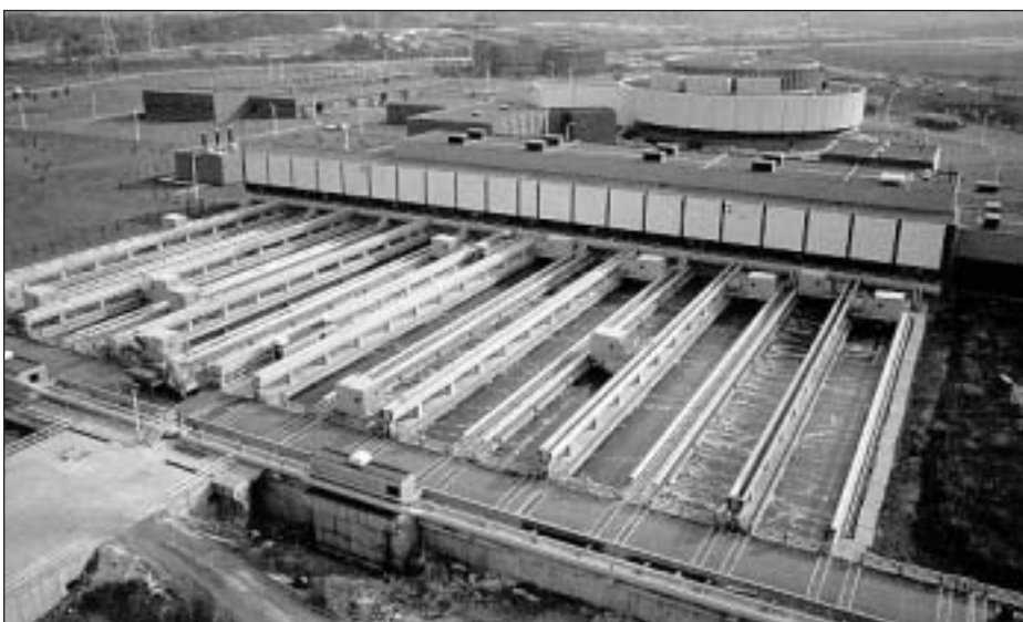
Station d'épuration de la Communauté urbaine de Montréal, la plus grande au Québec.
