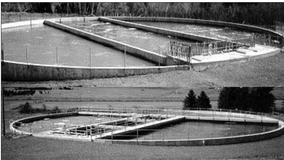
Étang aéré avec parois verticales en béton, technologie surtout utilisée pour les ouvrages de moindre envergure.
