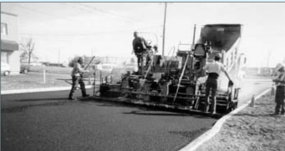
Pose d'enrobés avec bardeaux d'asphalte, rue Power à Drummondville.
