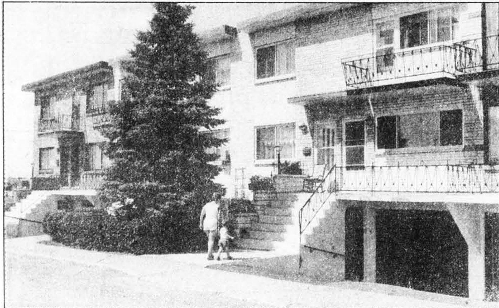
Parce qu'elles ont été construites sur un ancien dépotoir où sont enfouis des produits dangereux, six maisons de LaSalle seront détruites. L'ensemble des travaux — qui compren-
