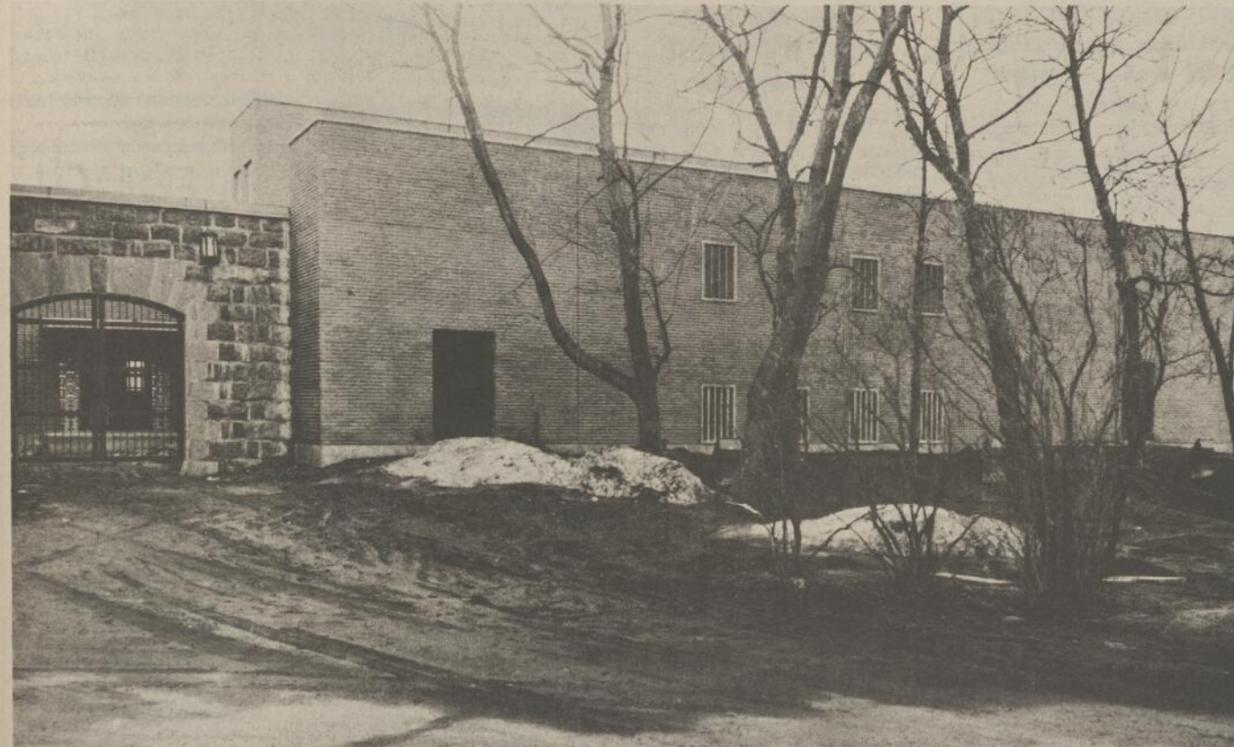
UNE VUE DE LA FACADE de la nouvelle prison de Cowansville, annexée au Palais de justice et située à 920, rue Principale, et l'inauguration a été faite en fin de se-
