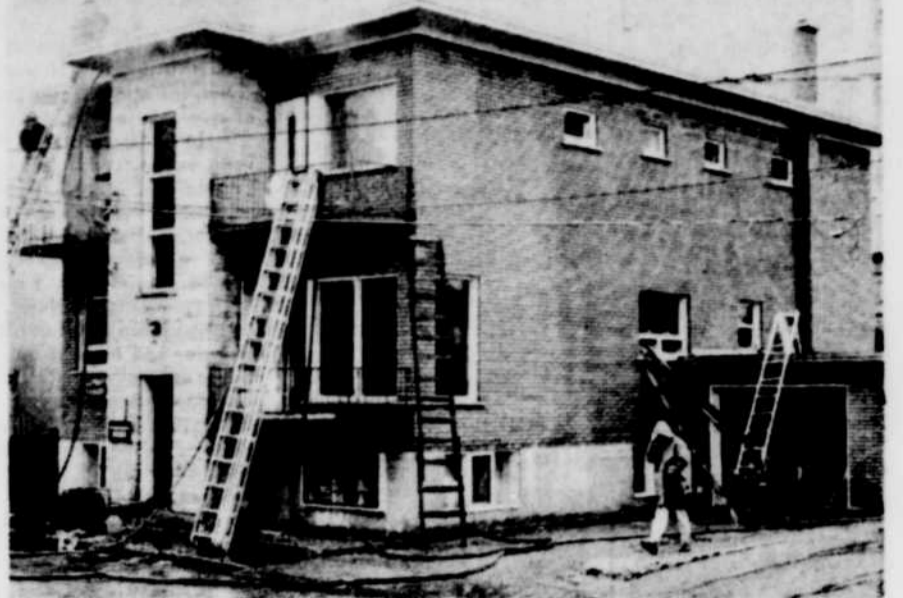
UN INCENDIE D'ORIGINE INCONNUE a complètement rasé l'intérieur de la demeure de M. Edouard Roger, hier avant-midi. Seuls les quatre murs sont restés debout alors que rien n'a pu être sauvé à l'intérieur. Les pompiers ont combattu l'élément destructeur pendant plus de deux heures.
