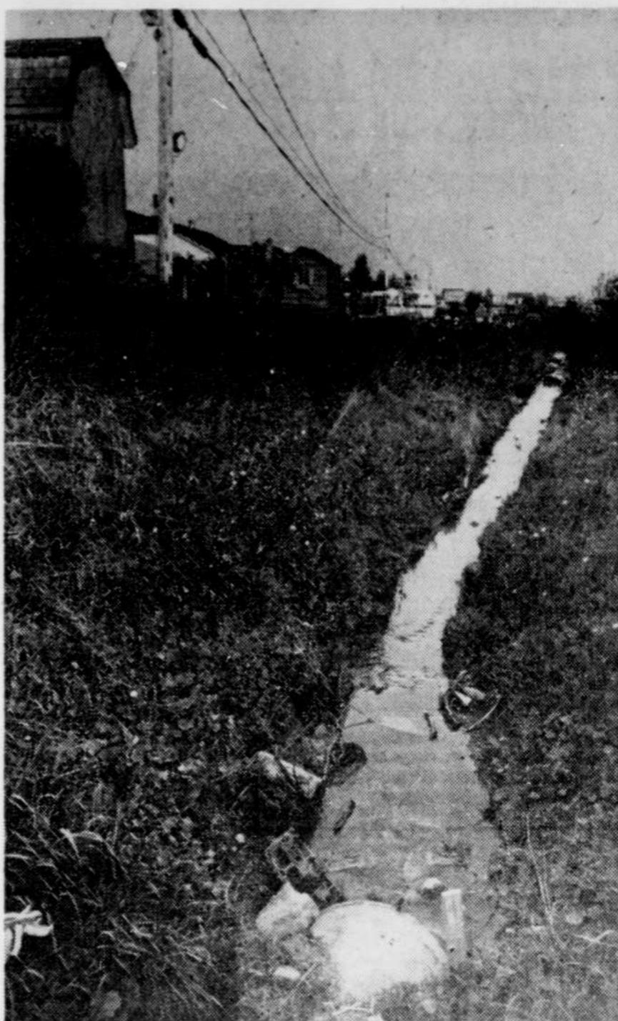
On tente d'accélérer la canalisation de ce ruisseau. Le Soleil, J.-M. Villeneuve
