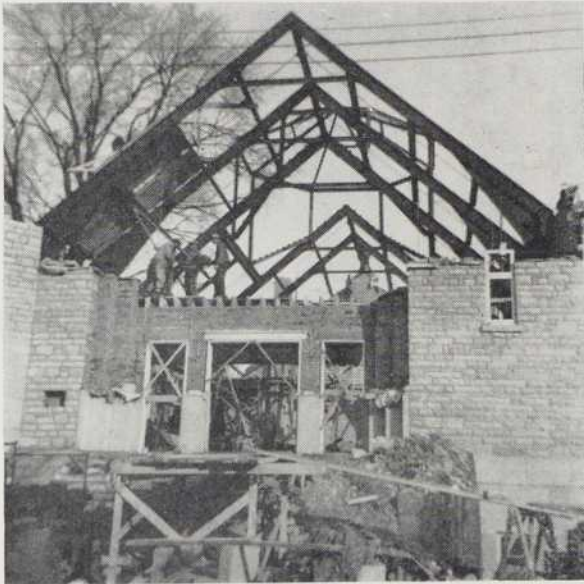
Vue de la façade avec cadre rigide.
