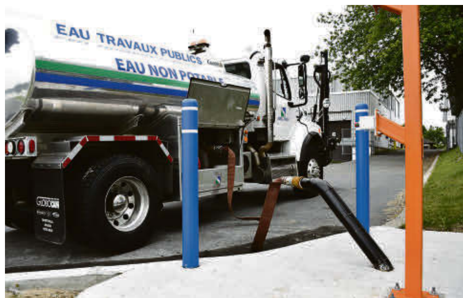
La prise d'eau brute a été installée derrière la Centrale de traitement d'eau de Sorel-Tracy. Photo gracieuseté
