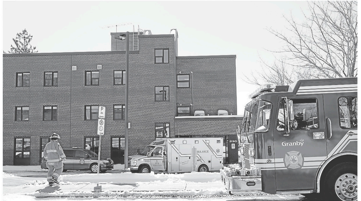
Les pompiers de Granby sont intervenus au centre d'hébergement Marie-Berthe-Couture à la suite d'un début d'incendie dans une chambre située au troisième étage. L'occupant a subi des brûlures. — PHOTO ALAIN DION
