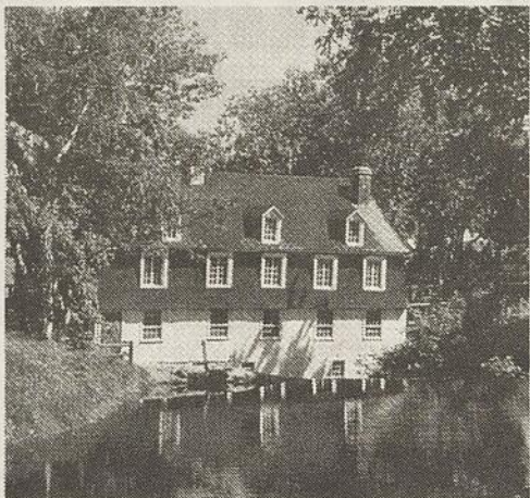
Le moulin de Beaumont, construit en 1821, est une attraction de choix dans Bellechasse.
