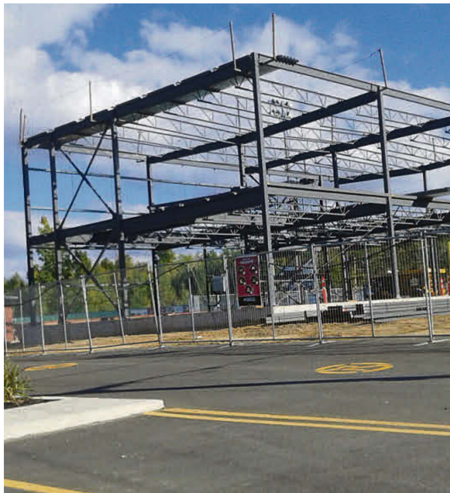
La Ville d'Acton Vale vient de démarrer la construction de son nouveau garage municipal, qui nécessitera des investissements de 1,6 million $.
