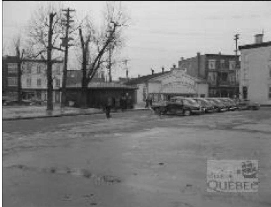
FIGURE 16. PHOTOGRAPHIE DU THÉÂTRE FRANÇAIS ET DE L'ÉDIFICE ADJACENT (ARCHIVES DE LA VILLE DE QUÉBEC NO Q-C1-14-N0023-N002390).
