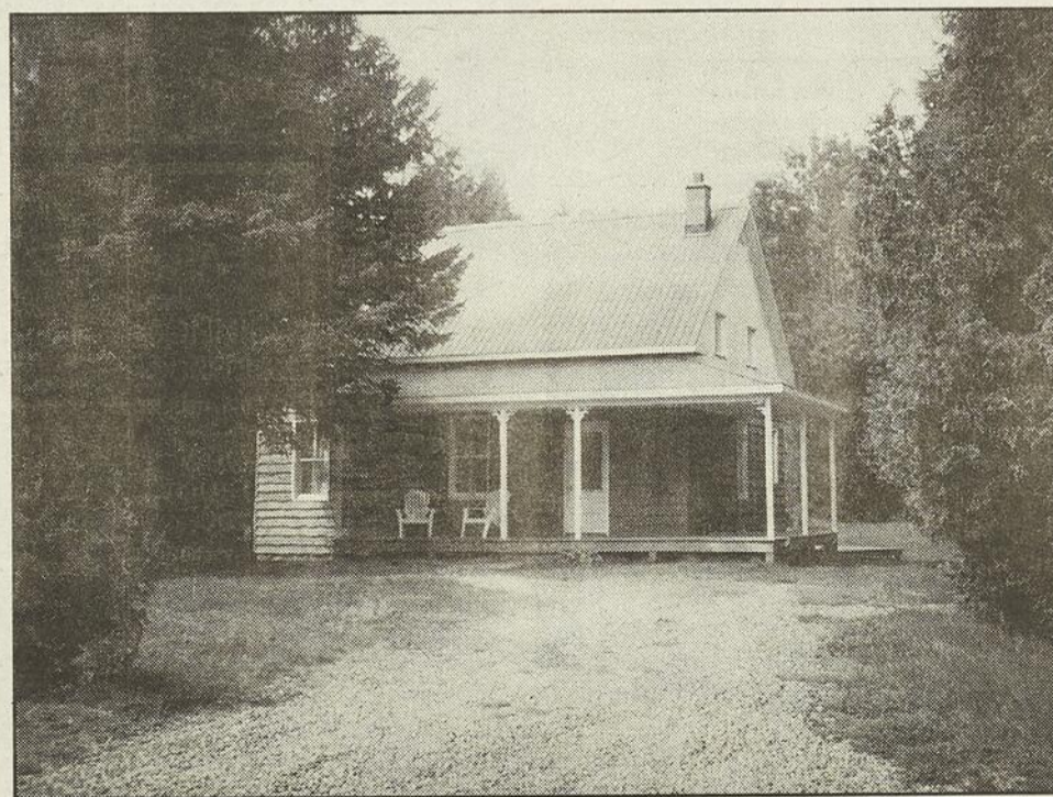
Maison historique au 3254, rue Lachaine
