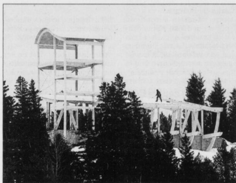
Les travaux se poursuivent au nouveau pavillon au Camp musical du Saguenay-Lac-Saint-Jean.
