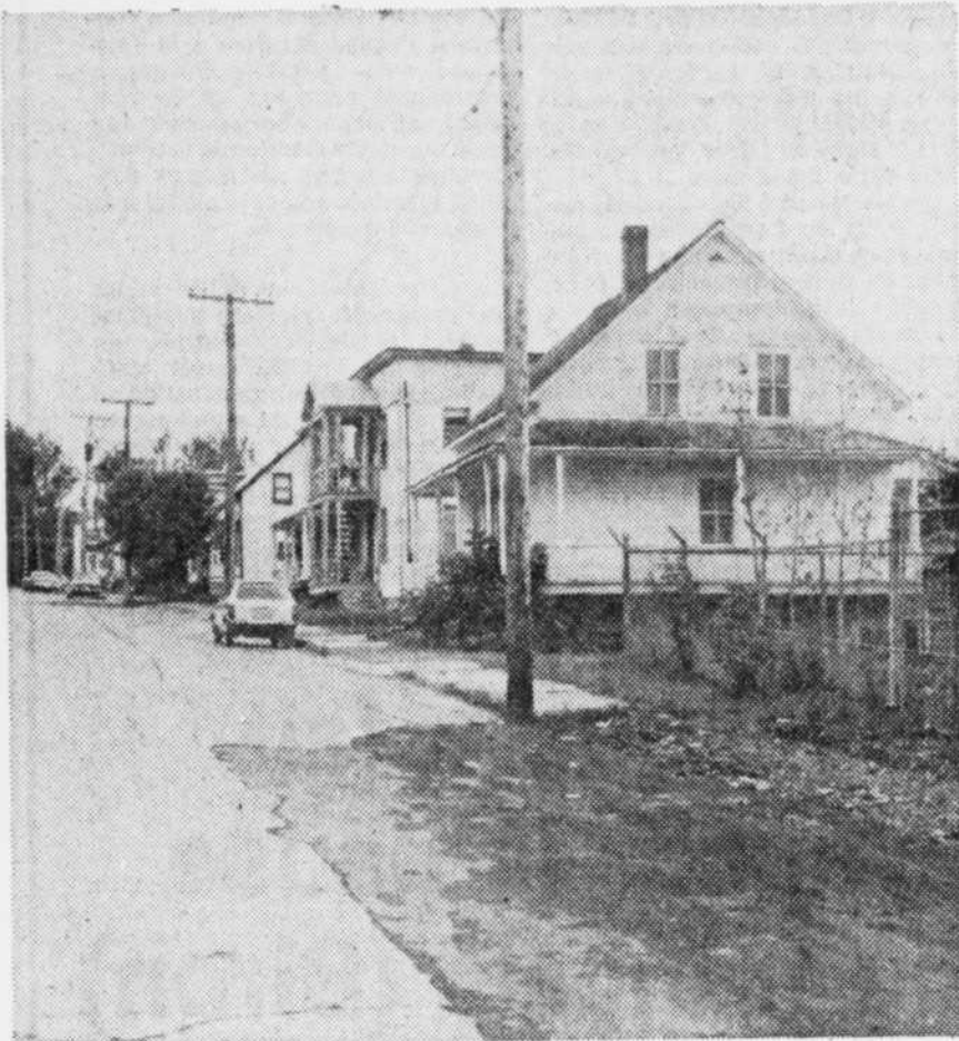
Une vue partielle de la rue Notre-Dame sud. A l'extrême droite, on voit la clôture longeant le cratère de la mine d'amiante King Beaver.
