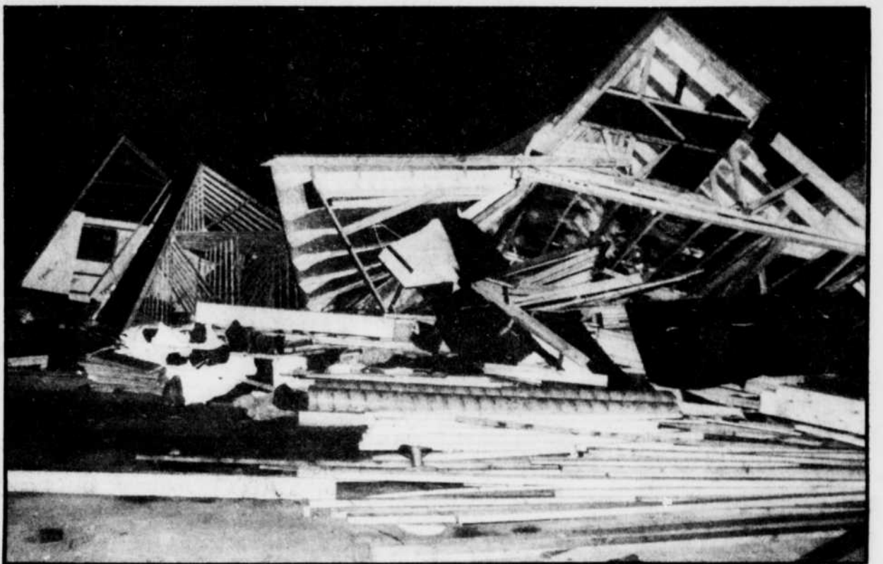
Un des "gestes d'éclat" de l'orage-surprise: la mise-à-sac d'une charpente sur le chantier de condominiums de l'ancien Lake Park, à Deauville. (Photo La Tribune par Stéphane Lemire)
