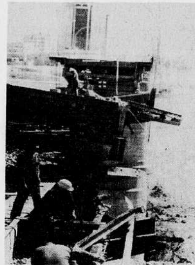
Les Irakiens s'affairent à reconstruire ce pont, l'un des trois qui ont été bombardés par les alliés à Bagdad. En tout, 91 ponts ont été détruits au pays durant les bombardements.
