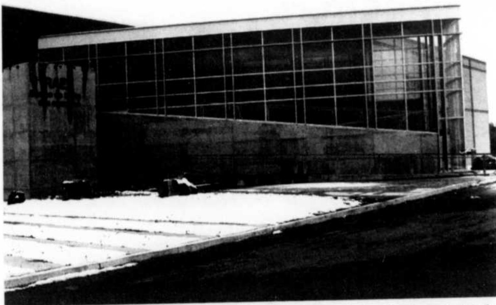
La conception de l'usine d'épuration ne serait aucunement en cause dans les récurrents bris de pompes. Il s'agirait probablement du type de pompes employées. (Photo d'archives)
