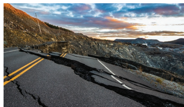
GRANDS PRIX 2019 – INFRASTRUCTURES DE TRANSPORT CONSTRUCTION DE LA NOUVELLE ROUTE 112 DANS CHAUDIÈRE-APPALACHES
