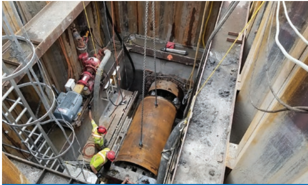
GRANDS PRIX 2019 – INFRASTRUCTURES URBAINES CONSTRUCTION D'UN COLLECTEUR SANITAIRE PAR MICROTUNNELIER
