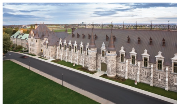
GRANDS PRIX 2019 – BÂTIMENT STRUCTURE RECONSTRUCTION DU MANÈGE MILITAIRE VOLTIGEURS DE QUÉBEC
