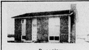
Bungalow Sous-sol fini Rang 3 ouest St-Anaclet Près du village.
