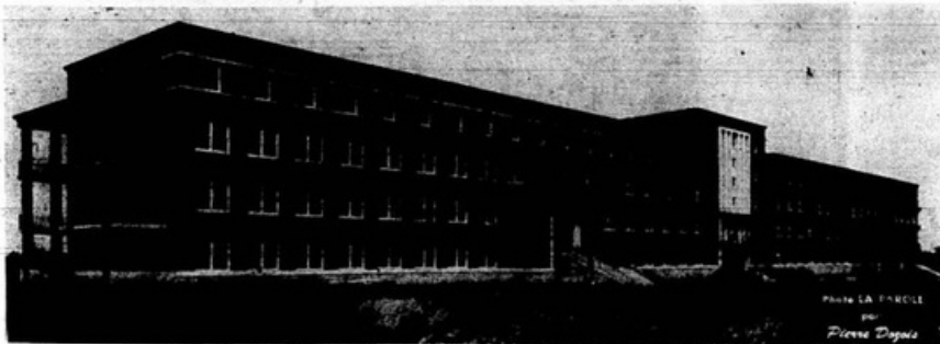
Façade du Collège
