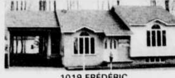
1019 FRÉDÉRIC Subvention «Mon taux mon toit». Travaux perm. payés. 4 c.c.
