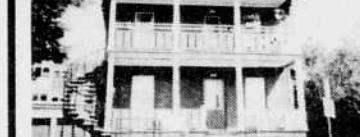
CENTRE. TRIPLEX tout brique, 2x4. Rapporté 6400$/m. non chauffé. 6 pces libre à l'acheteur. Logez-vous à bon compte! Toiture 2 ans + 3 garages.
