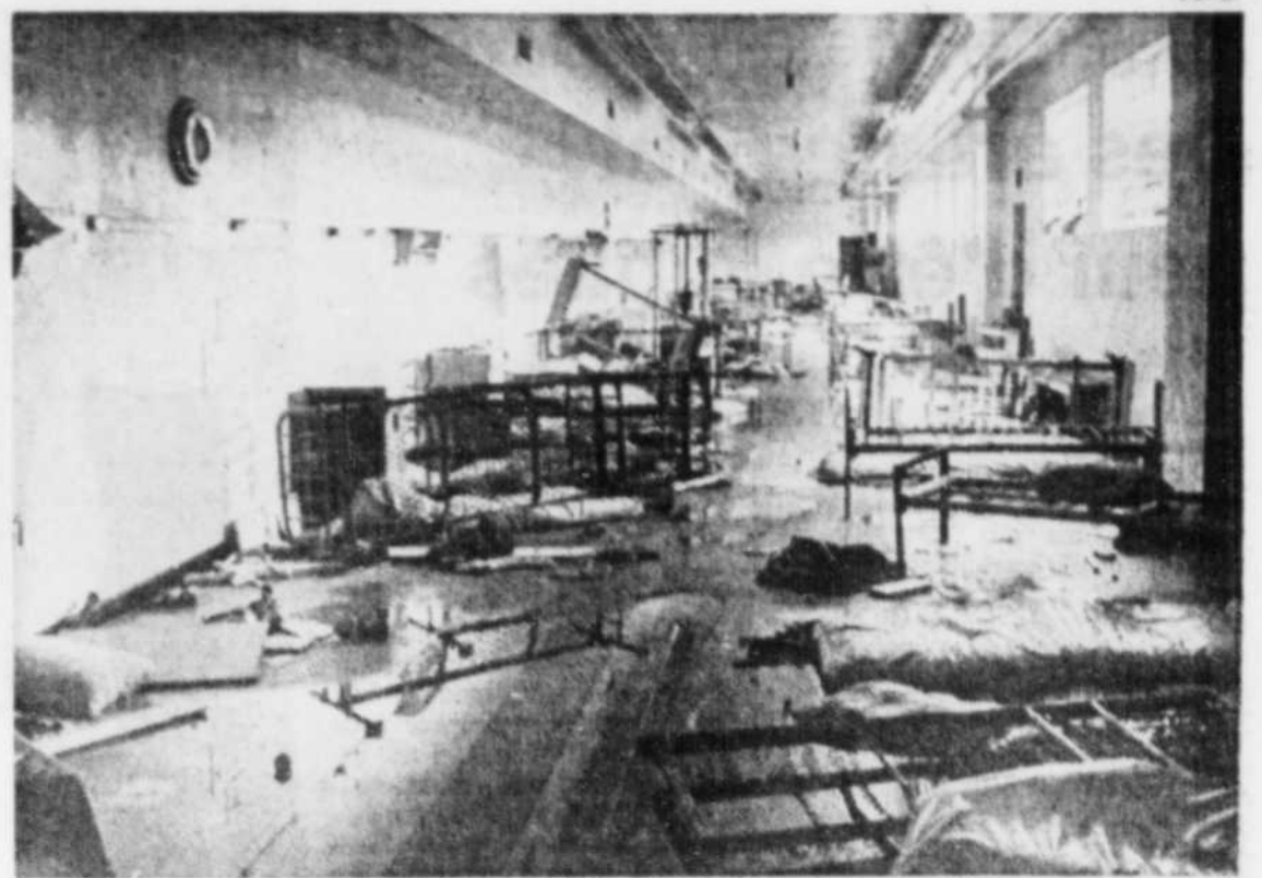
La prison a subi d'énormes dommages par le feu, l'eau et le saccage des détenus.
