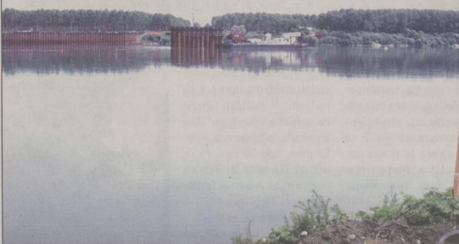
Cantiere sul Po a San Rocco al Porto (Lodi), veduta delle due sponde dove sorgerà il nuovo ponte ferroviario per l'alta velocità.
