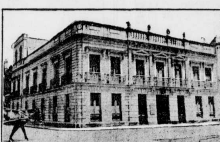
Le consulat des Etats-Unis, à Mexico, qui a été attaqué au cours d'une manifestation antimexicaine et qui a été endommagé par une pluie de pierres.
