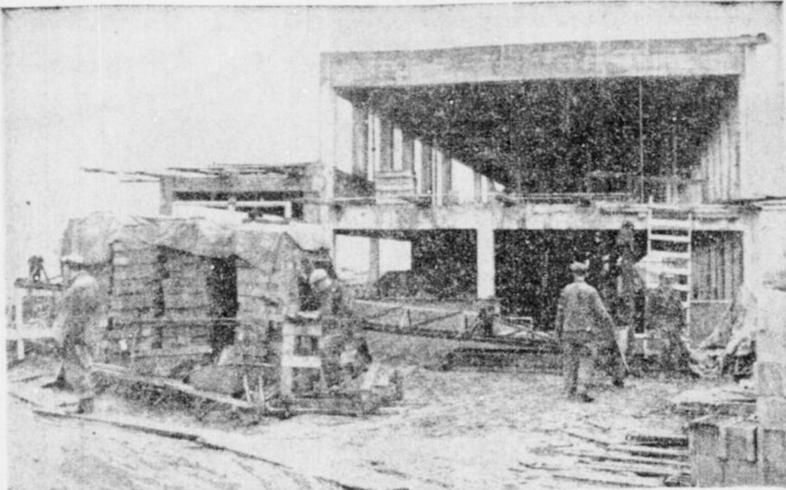
LES OUVRIERS A L'OEUVRE — La construction de quatre pavillons, pour la formation de la jeunesse par une méthode nouvelle d'enseignement individuel et personnel, que geront les dirigeants de Boscoville, progresse rapidement sur une élévation de terrain, en retrait de l'est du boulevard Gouin. Ci-haut la structure profonde de 40 pieds de l'un de ces pavillons.
