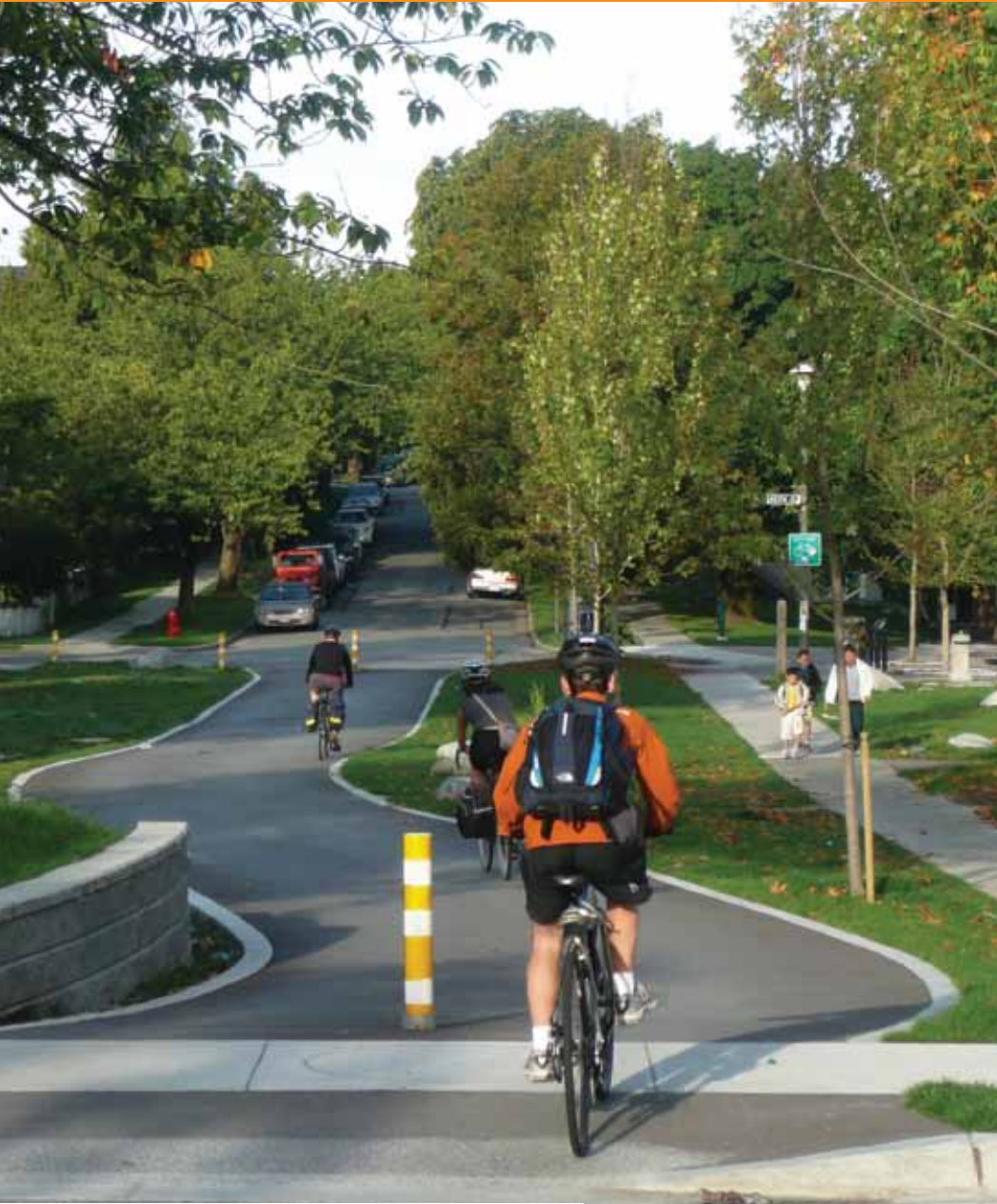
Fermeture de rue avec passage pour cyclistes, Vancouver
