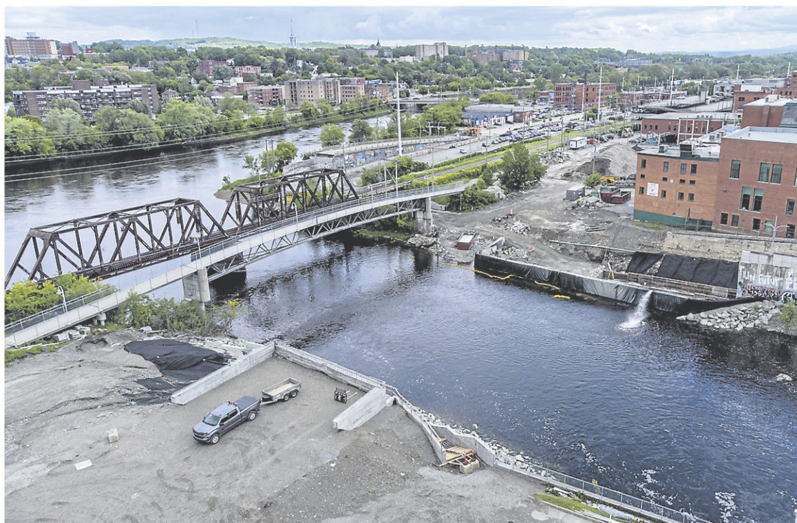
On peut maintenant visualiser l'axe du futur pont des Grandes-Fourches, ainsi que les culées de chaque côté de la rivière. — PHOTO LA TRIBUNE, JEAN ROY
