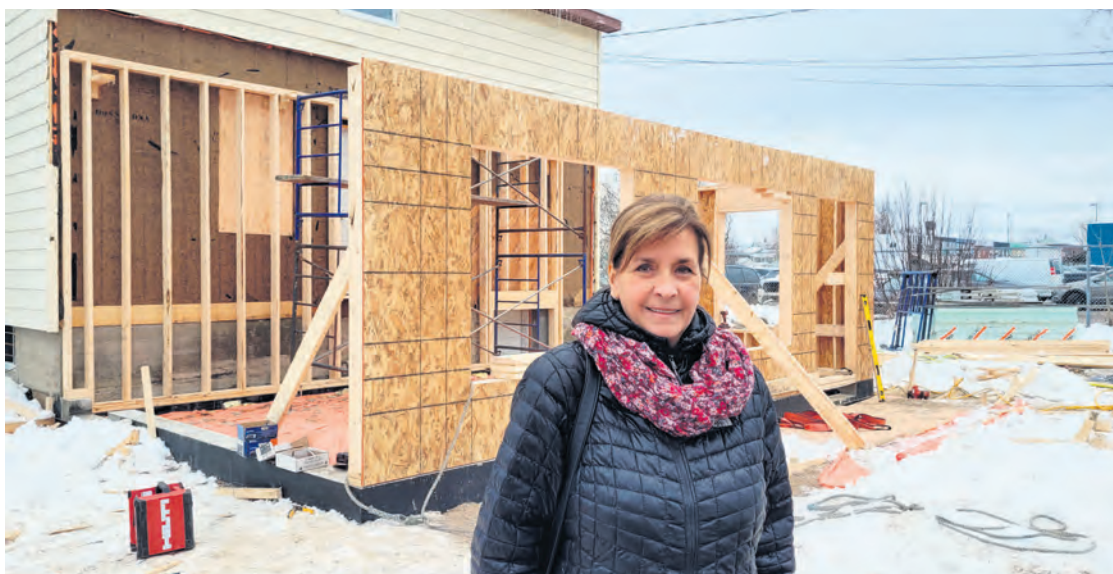
Dans quelques mois, le Centre de prévention du suicide Côte-Nord pourra offrir un lit de crise dédié aux personnes suicidaires, au grand bonheur de sa directrice générale, Gladys Tremblay. Des travaux d'agrandissement sont en cours dans l'édifice dont il est propriétaire.
