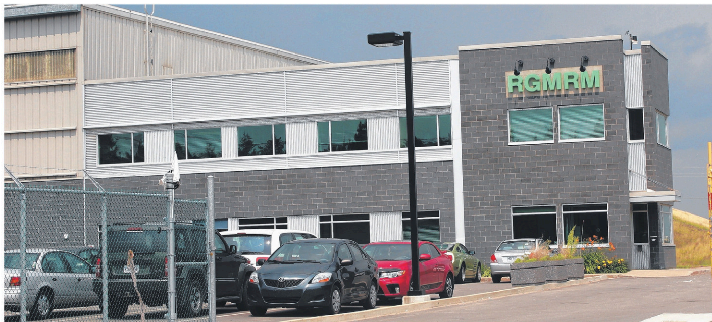
Les installations de la Régie de gestion des matières résiduelles de la Mauricie à Saint-Étienne-des-Grès. (Photo TC Media - Archives)
