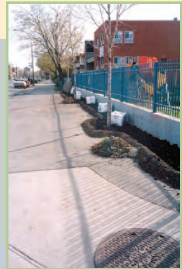
Début des travaux en 2002
