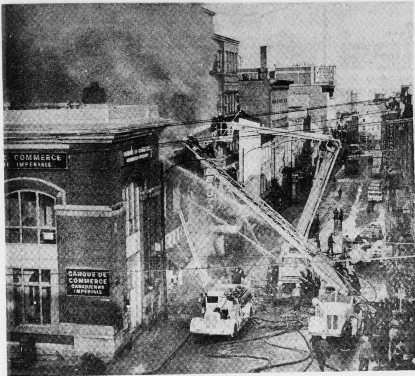
INCENDIE RUE SAINT-JEAN — Un incendie a complètement détruit un immeuble de deux étages, situé au 1014-1020 de la rue Saint-Jean, près de la rue d'Auteuil, dans le vieux Québec, hier après-midi. (Nouvelle et autres photos en page 13)
