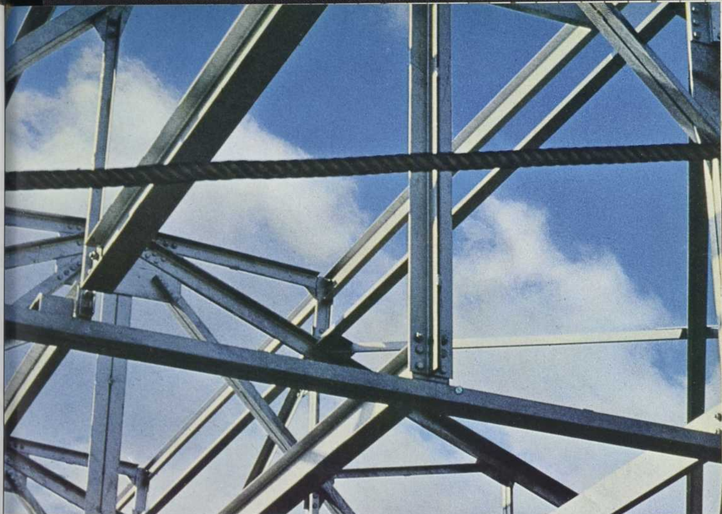
Acier de charpente zingué, au Centre de recherches sur les produits, à Sheridan Park, en Ontario.
