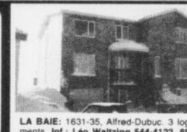
LA BAIE: 1631-35, Alfred-Dubuc. 3 logements. Inf.: Léo Waltzing 544-4122, 696-7424.
