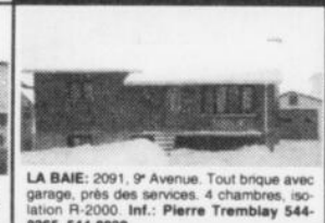
LA BAIE: 2091, 9 e Avenue. Tout briqué avec garage, près des services. 4 chambres, isolation R-2000. Inf.: Pierre Tremblay 544-6365, 544-8838.
