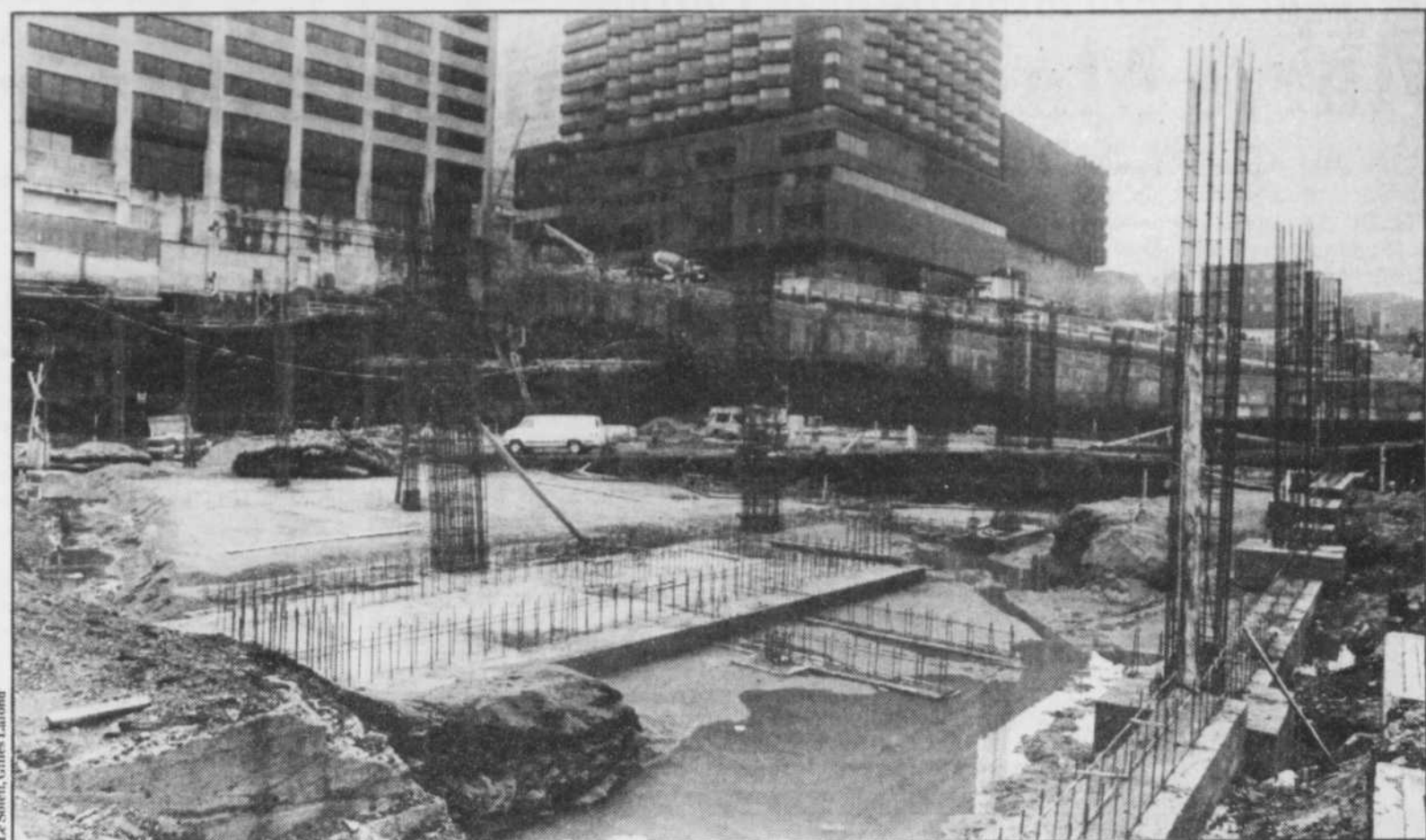
Les travaux de construction du Centre des congrès de Québec accusent un retard de deux semaines, mais son ouverture est toujours prévue pour septembre 1996.
