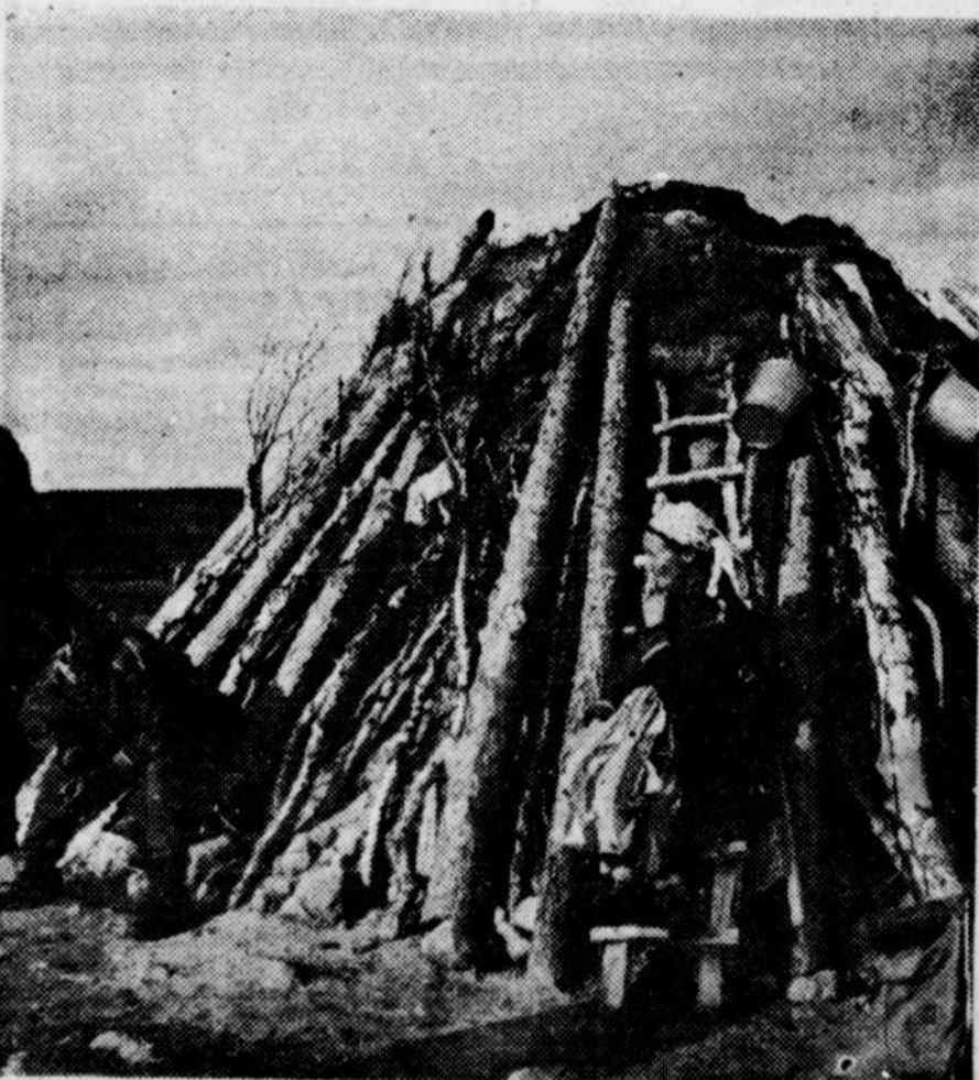
Pour un long séjour, la "kotta" est construite de plusieurs couches de rondins, disposés en forme de cônes et entre lesquelles on a mis des mottes de terre. (Unesco - Photo Jean Hardy).
