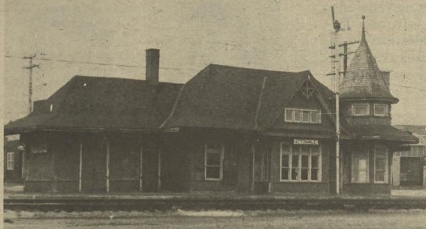
Depuis deux ans, la gare d'Acton Vale se détériore de plus en plus. Survivra-t-elle au temps et aux longues discussions? Un sursis d'un mois vient de lui être accordé!
