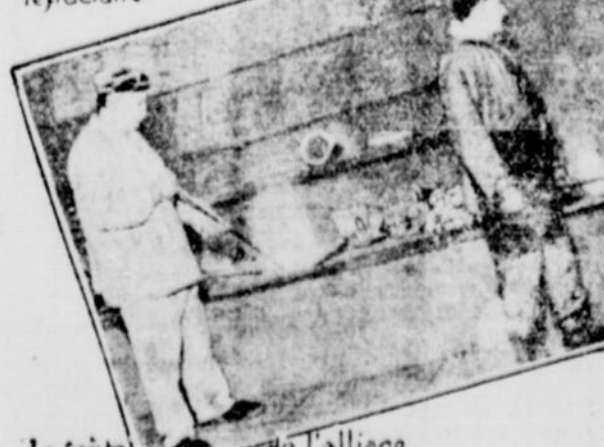
LA PREPARATION D'UN MOULE POUR PETITE STATUE. Lorsque les différentes parties du moule ont été réunies, les joints sont soignés, l'ouvrier soigne les joints avec soin au moyen d'un enduit réfractaire.
