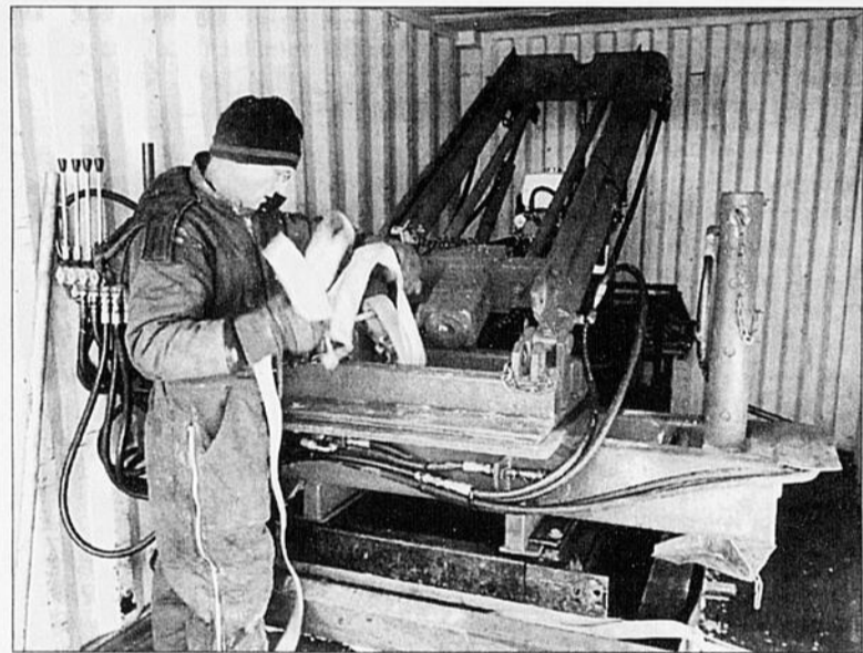
VÉRIFICATIONS - Yohan Lambert procède aux dernières vérifications sur l'un des appareils qui seront utilisés dans les mines de bauxite de Jamaïque.
