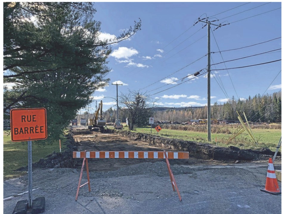
Les travaux de 6,5 M$ se poursuivront jusqu'à l'été 2023. (Photo gracieuseté)
