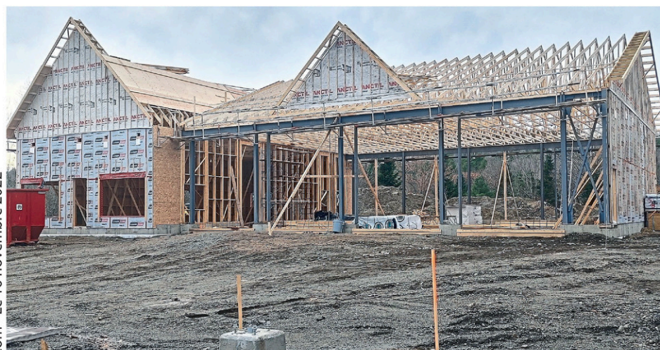
La construction de la caserne des incendies du Canton de Stanstead devrait se terminer l'été prochain. (Photo gracieuse)
