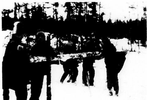
Construction de la poutre d'équilibre double pour le "combat de poche". Les Pionniers utilisent la technique du brelage pour assembler les morceaux de bois.
