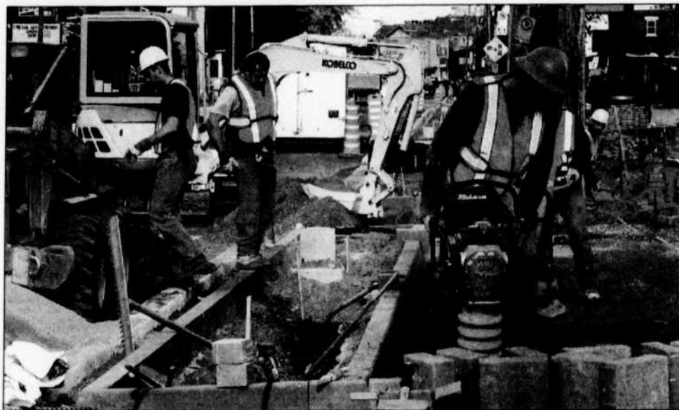
LES PHASES 2 et 3 du projet se poursuivront jusqu'à la mi-décembre prochain, dans la mesure où Dame Nature collaborera avec les entrepreneurs mandatés pour ce chantier. (Photo: Courtoisie)
