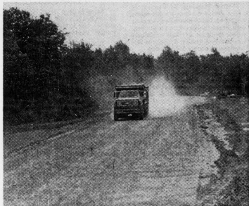
Les travaux vont bon train et ce nouveau tronçon d'autoroute constituera un actif d'importance pour la Beauce.
