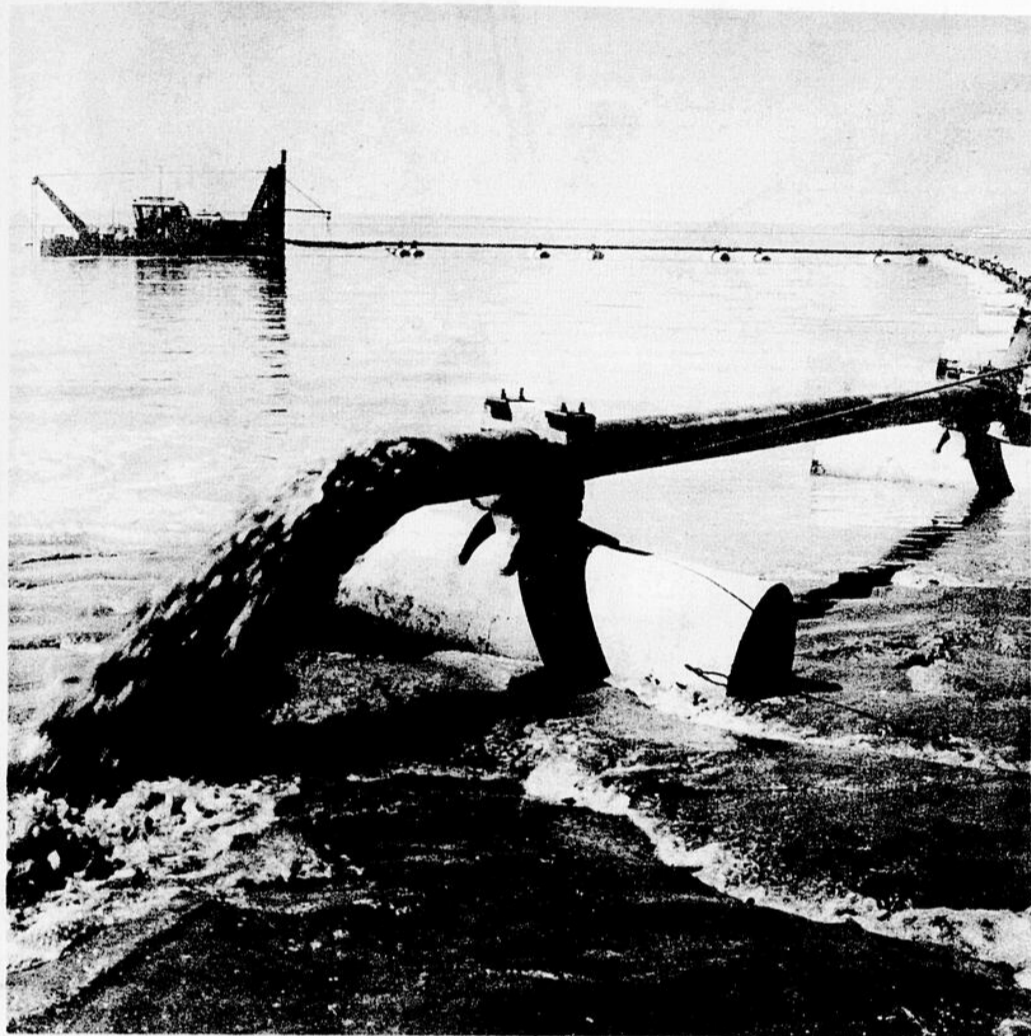
La drague Maria Chapdeleine est de nouveau à l'oeuvre sur les rives du Lac. On voit ici un secteur de rive à refaire avec du sable que l'eau placera suivant un profil d'équilibre naturel.
