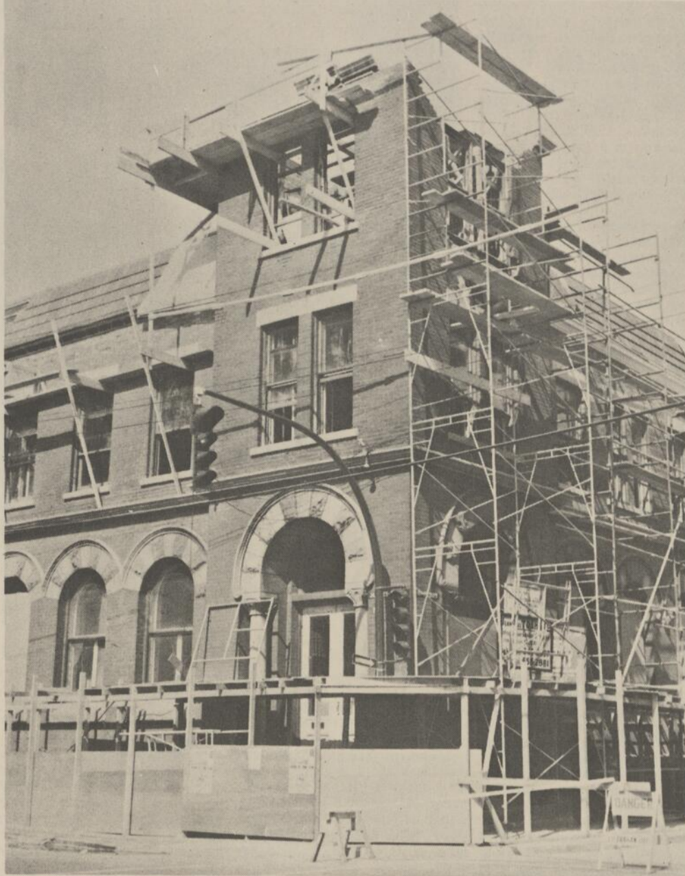
Les travaux de réparation de l'édifice de la Bibliothèque municipale de Saint-Jean vont bon train. Ces travaux exécutés par les ouvriers spécialisés de la firme Jean-Paul Trahan Ltée de Saint-Jean comptent terminer les travaux sur la toiture et à l'intérieur de l'édifice d'ici les prochaines semaines.
