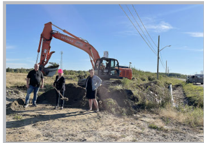
► Un nouveau développement résidentiel est en construction, sur la rue Talbot, à Laurier-Station.
