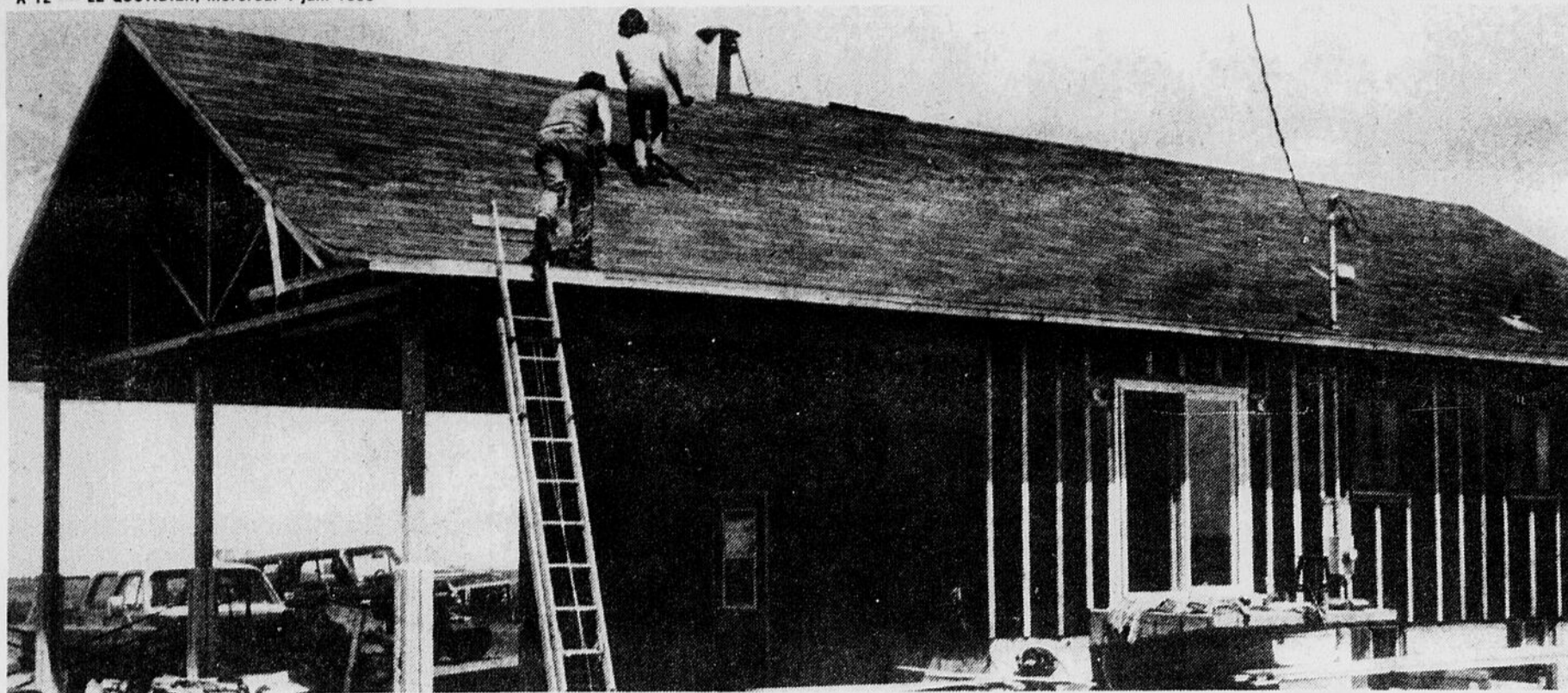
CONSTRUCTION — La maison unifamiliale en rangée est toujours populaire mais de moins en moins accessible. Le coût des terrains et des infrastructures sont les principales causes de l'augmentation du prix de la maison.
